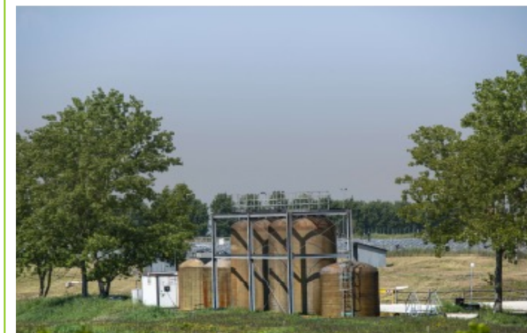
Ph: dall'alto in basso: entrata del parco fotovoltaico, l'impianto nel territorio della ex discarica, impianto di raccolta del percolato dell'ex discarica
