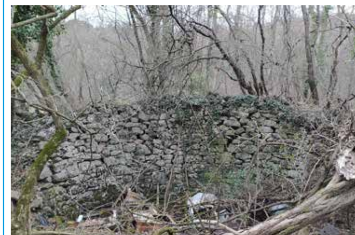
Ph: "Ghiacciaie in stato di degrado" Foto di Monica Fontanot (alunna della classe). Le ghiacciaie, sempre realizzate in prossimità di specchi d'acqua, sono profonde fosse murate che venivano utilizzate per conservarvi il ghiaccio formatosi negli stagni durante l'inverno; il ghiaccio veniva coperto da foglie di faggio secco per ragioni di conservazione, e quindi venduto sia a Trieste che persino in Egitto.
