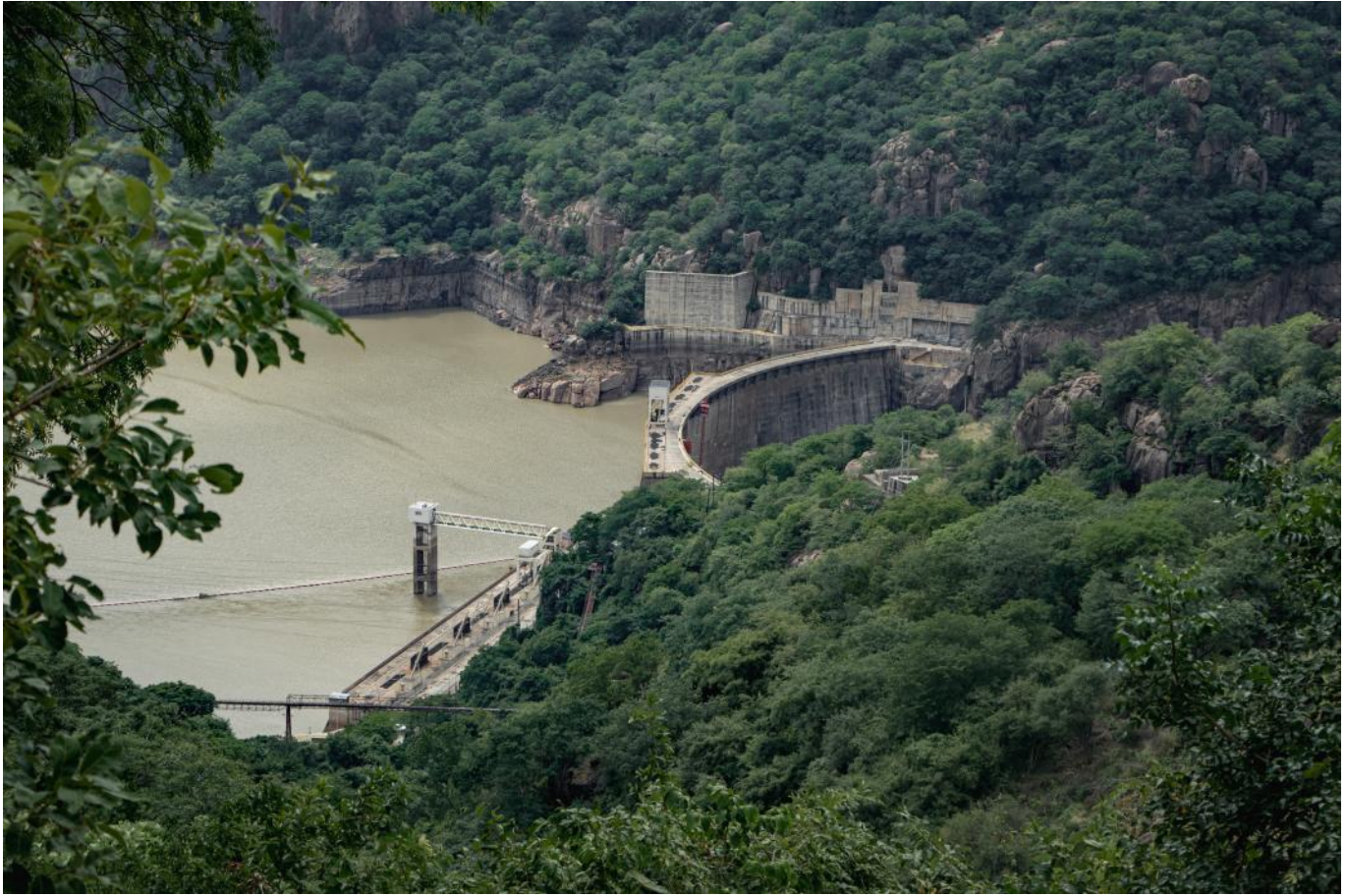
Cahora Bassa dam.
